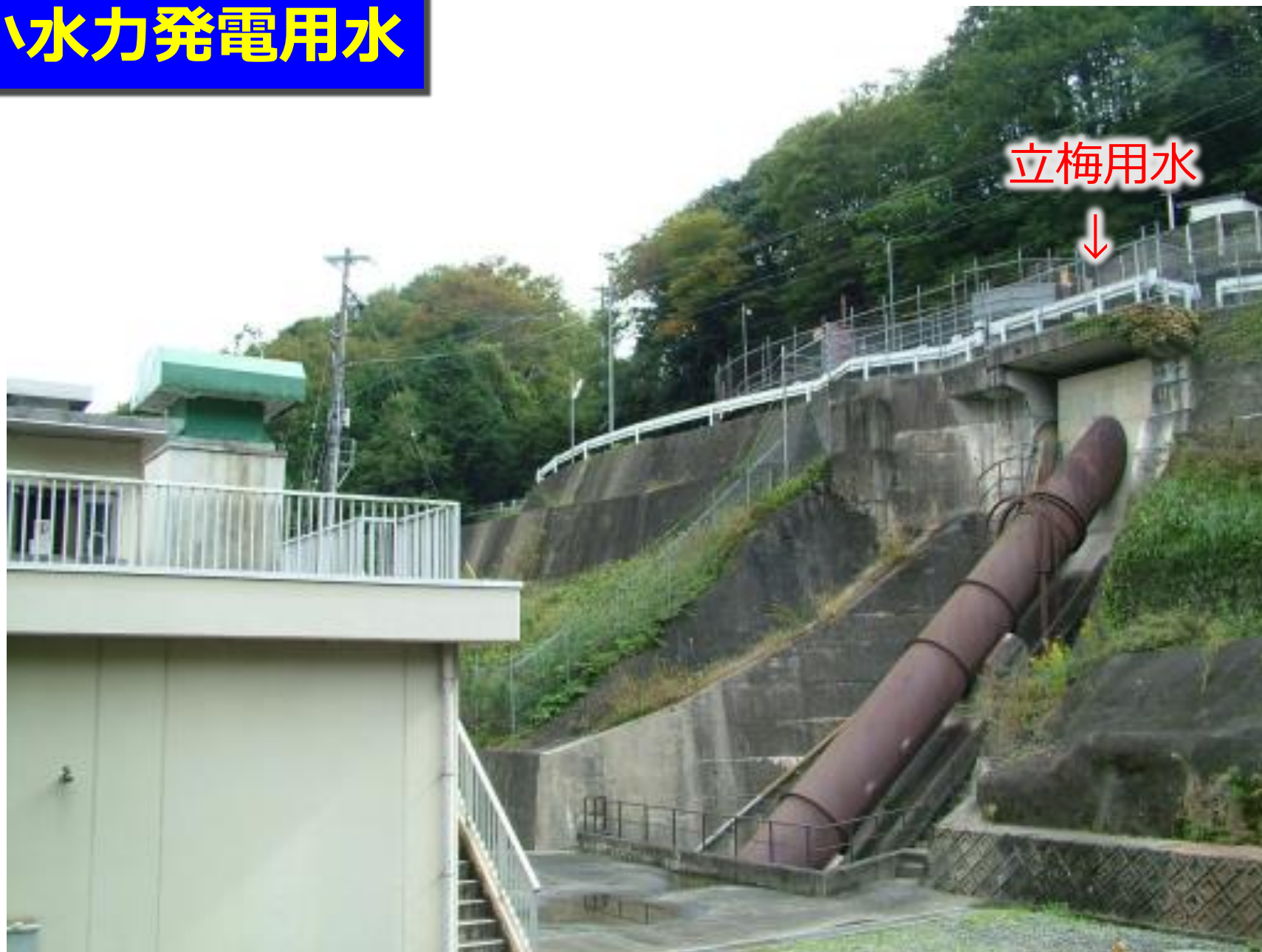
波多瀬発電所（大正10年～）
