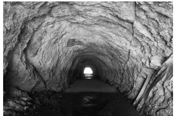
【丹生・柳谷トンネル ほか2ヶ所】
